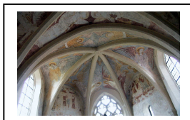
Toit en dôme :
